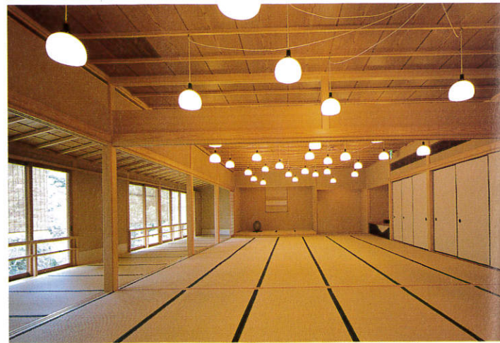
2階大広間（手前15畳、奥27畳）。天井はスギ中空化粧石膏ボード張りおよび手繰天井。
