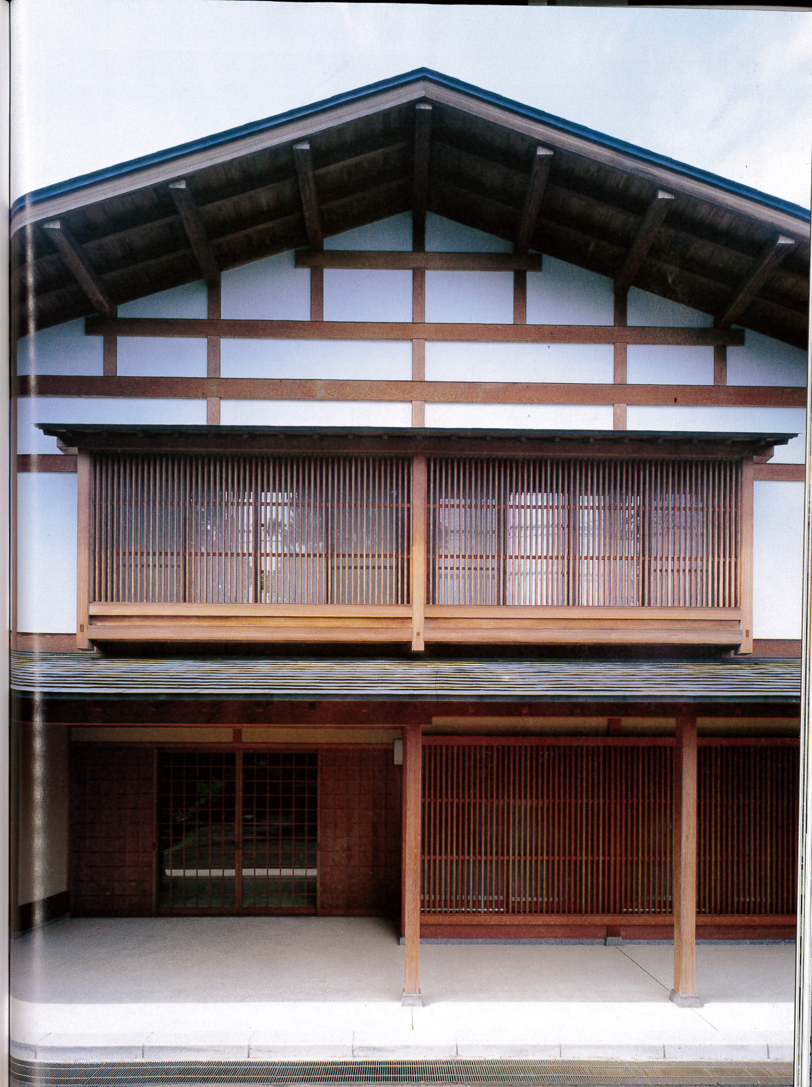
上：玄関前から取次を見る。玄関の床は繊維入珪藻土。壁は京織帷壁。／右頁：約8年で全面改修された旅館。雁木と正面玄関を見る。屋根は銅板一文字葺き、カラ一鉄板長尺一文字葺き、外壁はモルタル塗漆喰調仕上げ、開口部は木製ガラス戸（一部アルミサッシュ）とされている。
