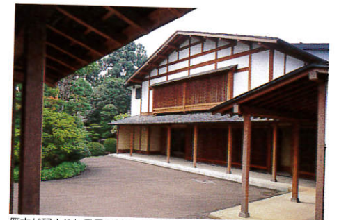
雁木が配された母屋の外観。手前左は蔵。
